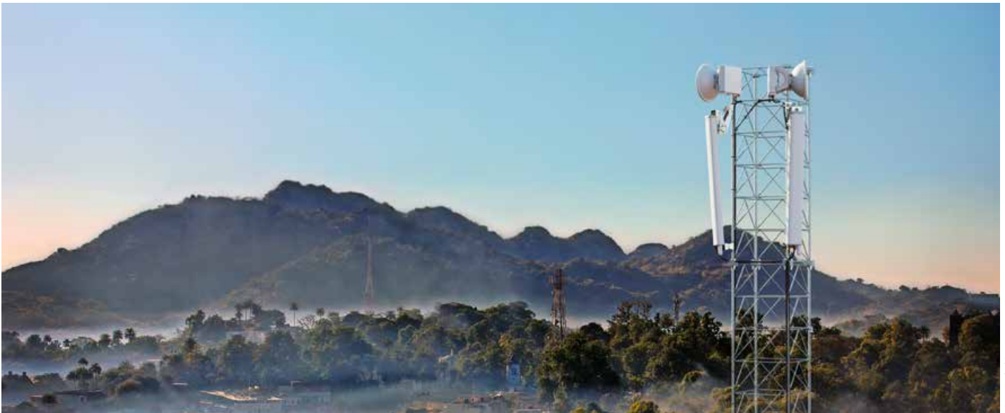
Två Ericsson MINI-LINK 6366, 0,6-metersantennor (tvåvägs), PSI-lösning installerade i Indien.
