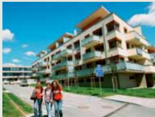
Skanska har ansvarat för såväl markförvärv, planering, utformning, byggnation som försäljning av bostadsområdet Botanica i Prag.
