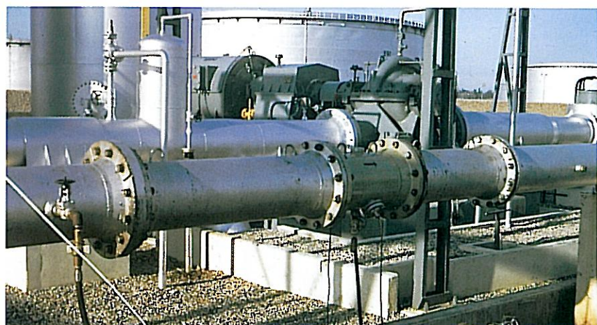
Holländska Hitmas kvalificerade säkerhetsventiler motverkar explosionsrisk och övertryck i bl a raffinaderier och kemisk industri.
