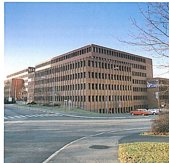
Fundaments största fastighet är belägen i Solna och utgör 58.600 kvm, huvudsakligen kontorsyta.
