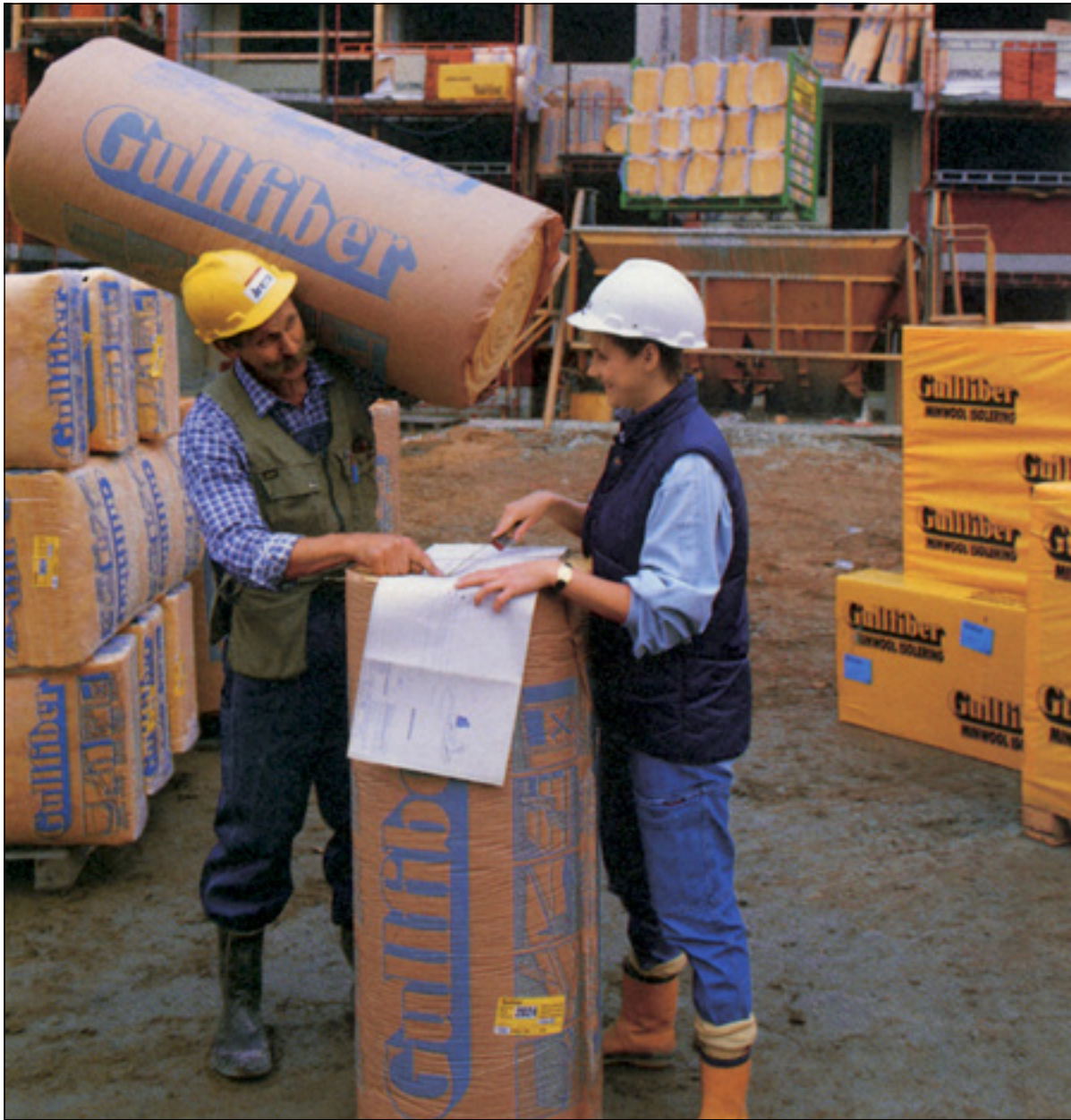
Leverans av Gullfiber (isolermaterial av glasull) till byggarbetsplats 1985.
