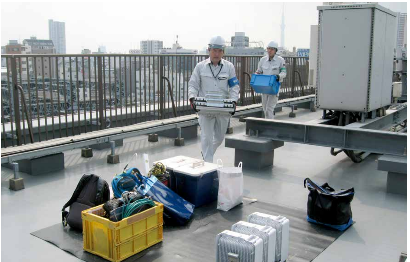
Tekniker installerar radioutrustning i Japan och är noga med att ha en säker arbetsmiljö på ett tak.
